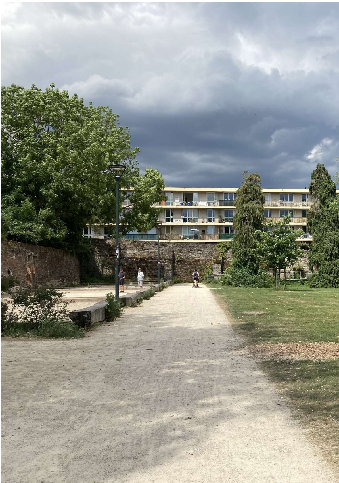
Terrains de pétanque et logements sociaux à Rennes, France.
