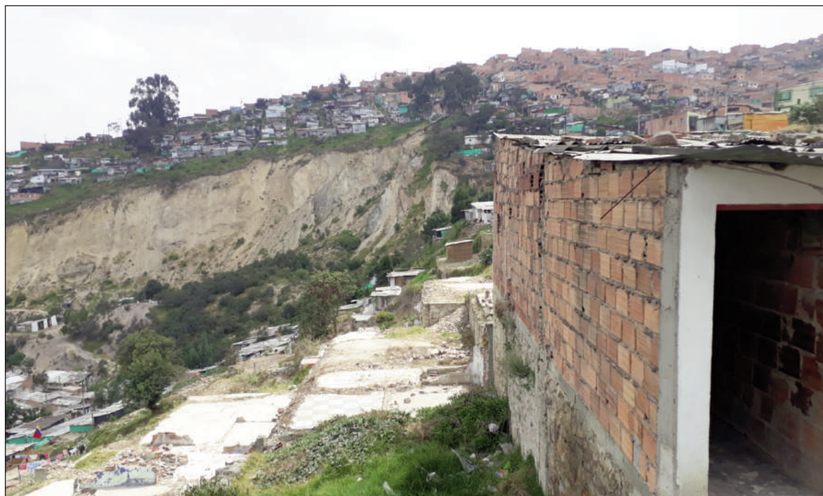
Loma Linda, Soacha, Bogotá, una de las comunidades con las que el proyecto trabaja. La anterior excavación de arena significa que las personas reubicadas en este terreno están expuestas al riesgo de deslizamiento y subsidencia severa y rápida. Los incendios también representan un riesgo.
